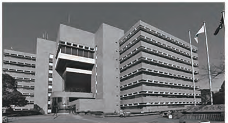
武蔵野市役所庁舎(提供:武蔵野市)
