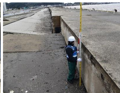
港湾被災状況調査
